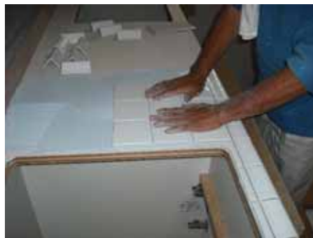
・タイルを張りつけている様子
