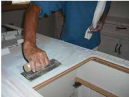
・専用接着剤を塗布している様子
