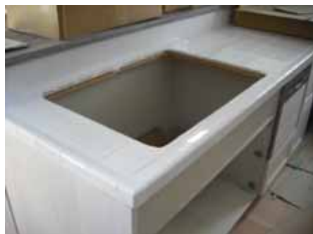
・タイル目地詰完了
